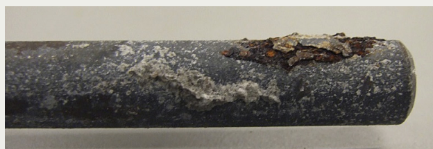
Figur 3. Korrosion på stål som varit ingjuten i bruk med 1% Cl per cementvikt och exponerats i 97% relativ fuktighet under 15 månader.
